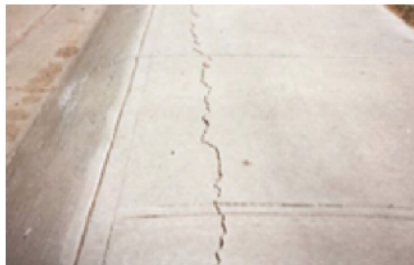
Deficient crack
