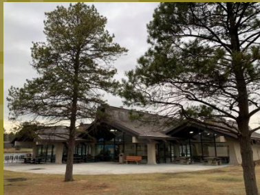
Hawrelak Park Pavilions (5 Structures)
